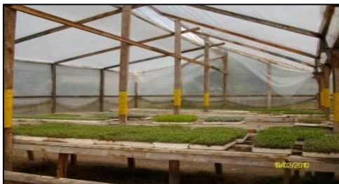
Gráfico N° 26. Invernadero modelo construido con caña guadua
