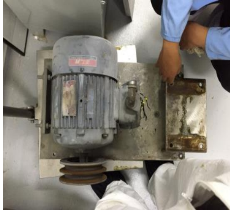
Figura 52 - Mantenimiento de motor
