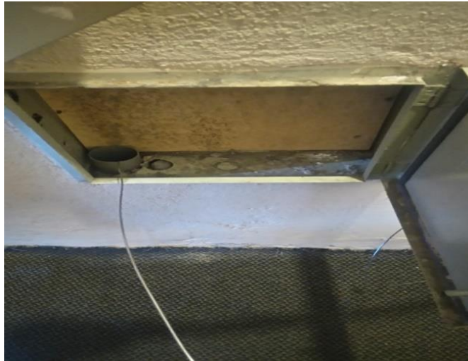
Figura 25: Paso de alambre guía en ductos para paso de cableado
