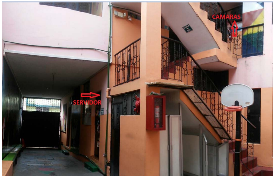
Imagen 31: Vista posterior para el cableado
