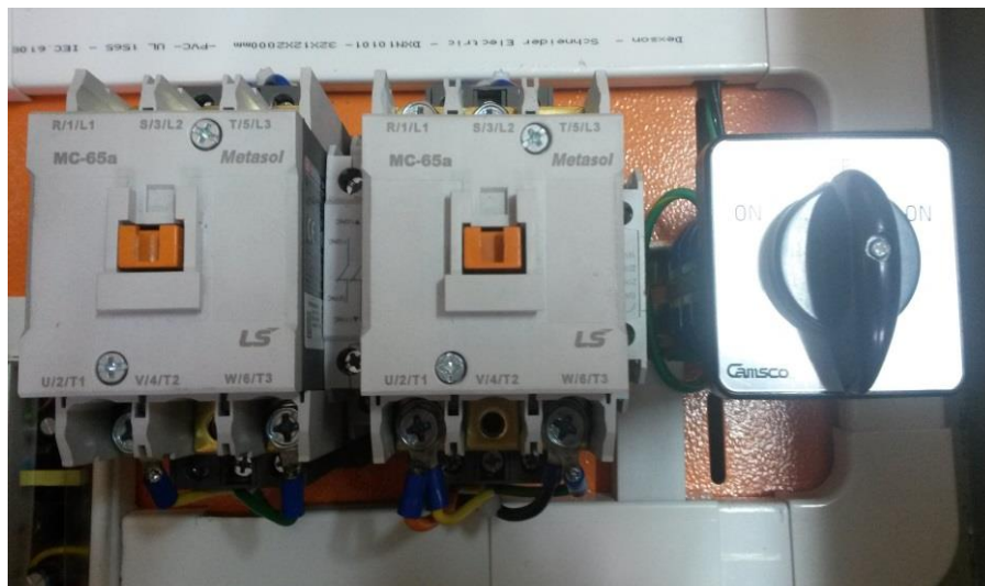
Gráfico 29.- Contactor LG 65 A / 110V bloqueo mecánico
