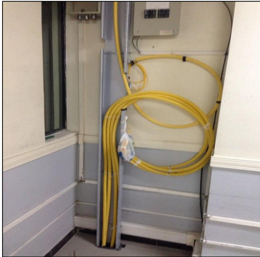
Figura 36: Sujeción de las mangueras flexibles corrugadas a la canaleta metálica
