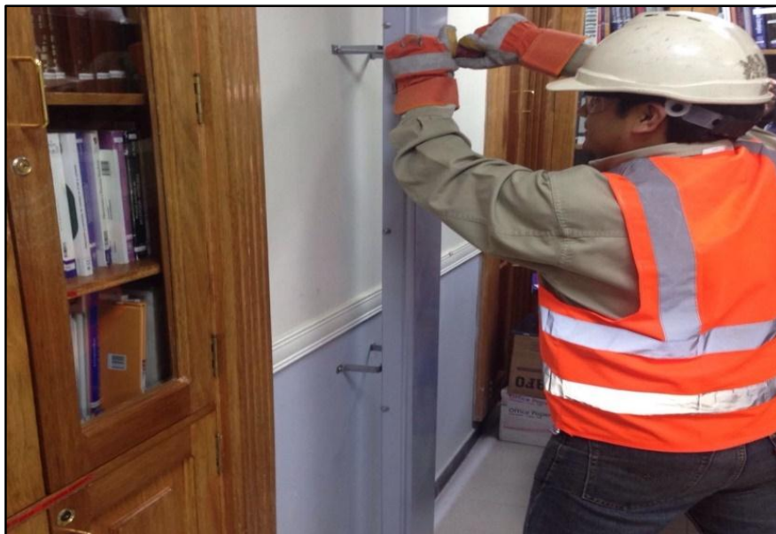
Figura 26: Instalación de canaletas cerradas o bandejas portacables
