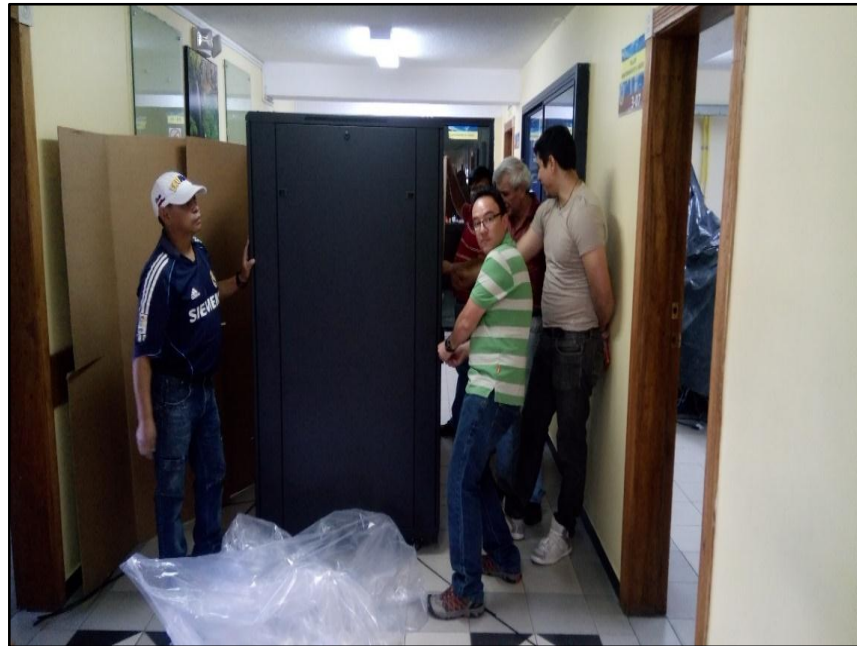
Figura 43: Instalación del rack en el tercer piso
