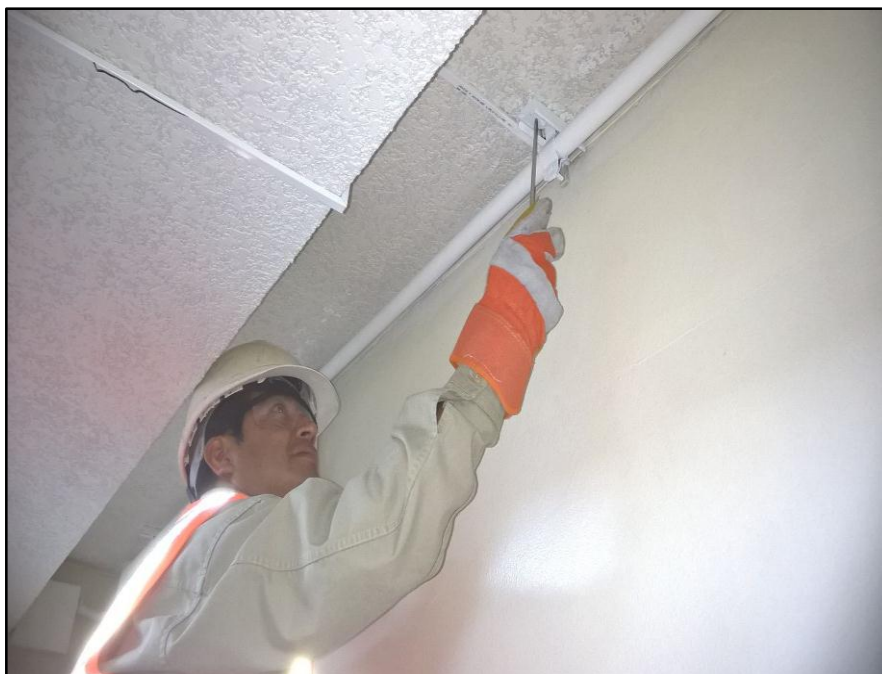
Figura 34: Instalación de la tubería conduit de 1 pulgada”
