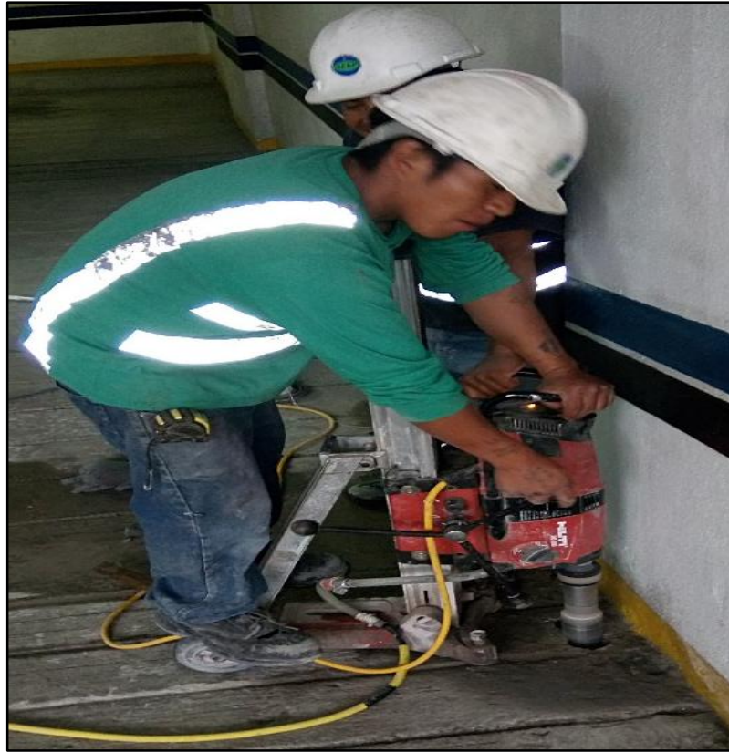
Figura 18: Equipo de perforación de losas con taladro sacabocados.
