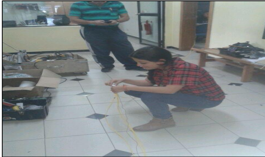
Figura 39: Preparación de los patch cord para ser introducidos en la tubería Conduit
