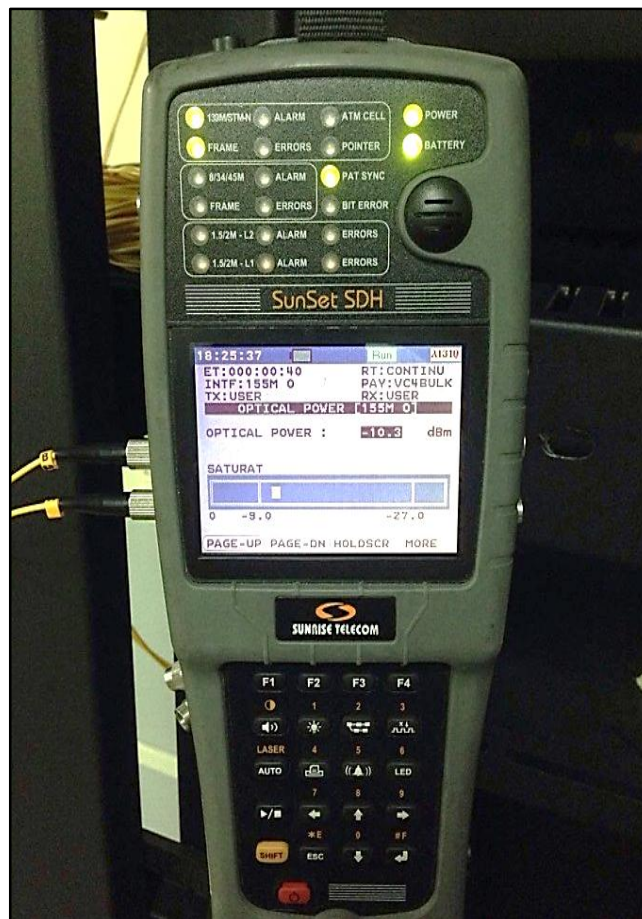
Figura 71: Analizador de tramas SDH en medición de los patch cord del piso 2
