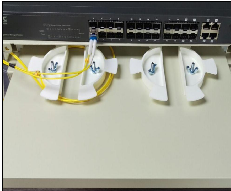
Figura 51: Colocación de patch cord de 1.5 metros en el organizador horizontal
