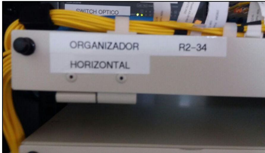
Figura 61: Etiquetado del organizador horizontal.
