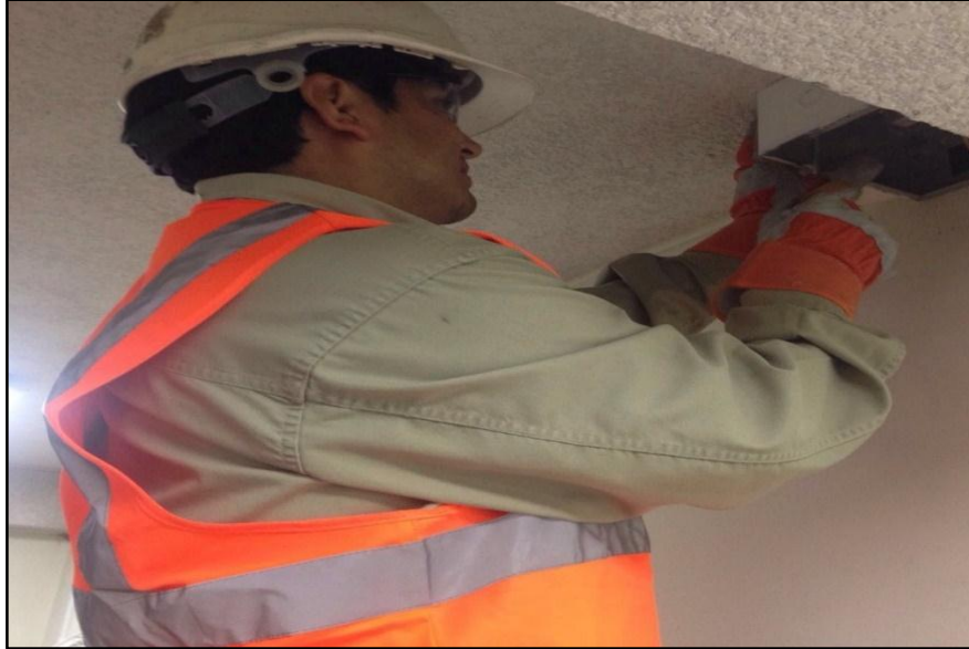
Figura 32: Instalación de tuberías, accesorios y cajas de revisión
