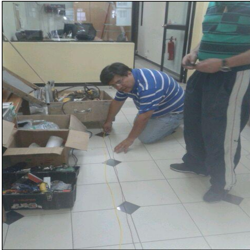
Figura 37: Preparación de los patch cord para ser introducidos en las mangueras corrugadas
