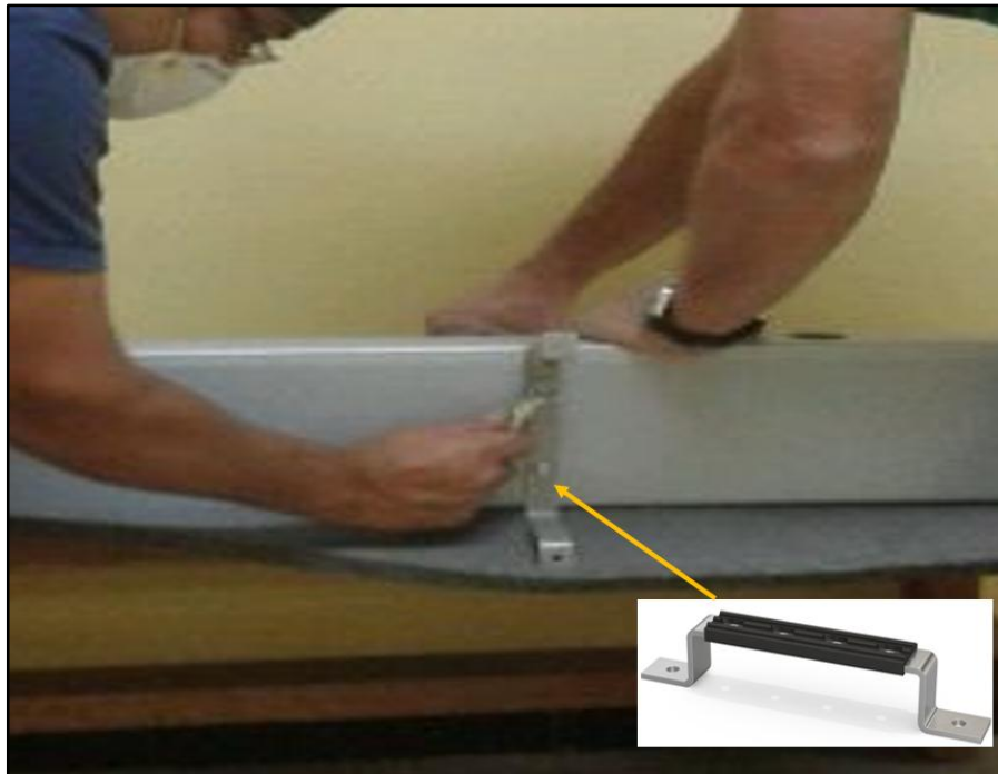
Figura 22: Soporte base de canaleta metálica cerrada de 15cm x 5cm
