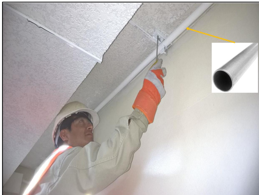
Figura 28: Instalación de tubos Conduit de 1 pulgada
