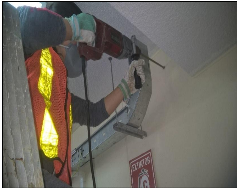
Figura 19: Perforación de vigas en proceso.
