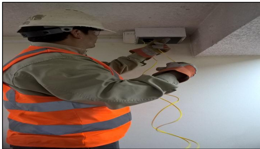
Figura 40: Paso de cables de fibra óptica por la tubería
