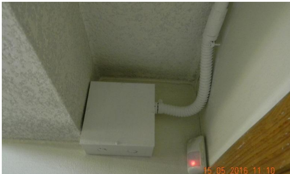
Figura 44: Acoplamiento de los tubos a las cajas de revisión
