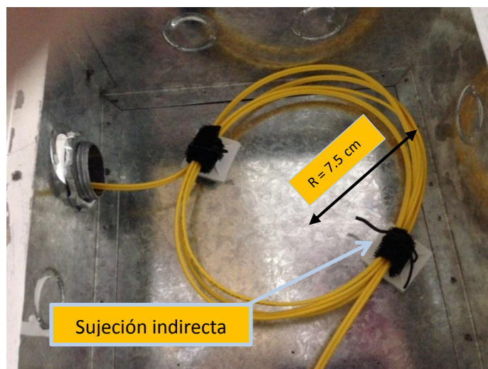
Figura 46: Fibra en las cajas de revisión Fuente: Universidad Tecnológica Israel
