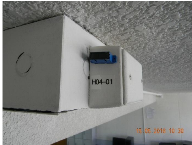
Figura 47: Conector dúplex de final de fibra
