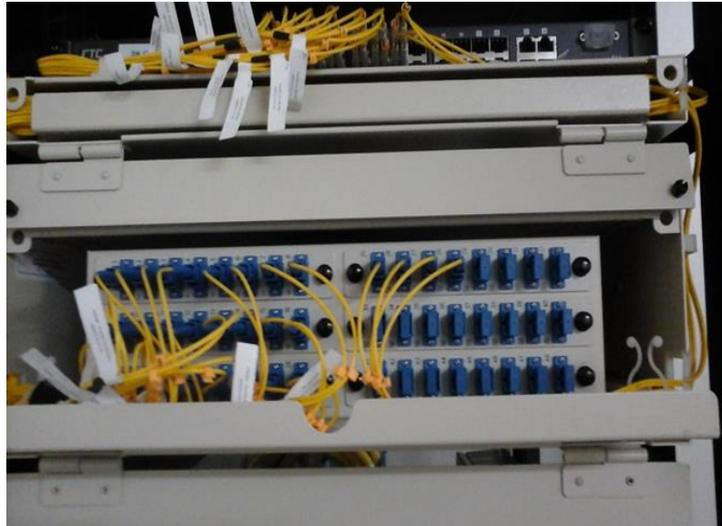
Figura 30 Etiquetado ODF, Switch, fibra óptica
