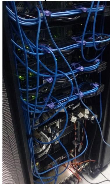
**Figura 19: Foto Posterior de los Servidores IBM en el que se observa las PDU's instaladas en el rack con su respectivo cableado.**
