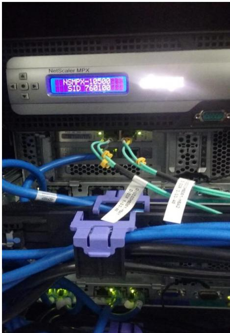
**Figura 20: Foto del cableado de fibra realizado al Servidor de Base de Datos.**
