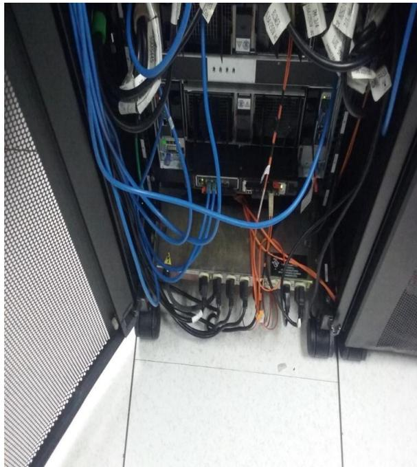
**Figura 21: Foto Posterior de los Servidores IBM en el que se observa las PDUs instaladas en el rack**
