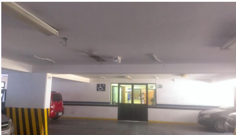
Figura 3.13 Parqueadero subterráneo antes de ser automatizado.
