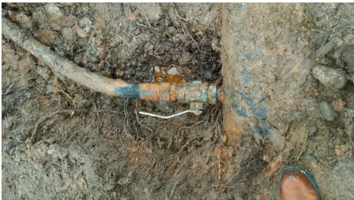
15.- Figura - Conexión Clandestina - Robo de Petróleo Línea de 12”
